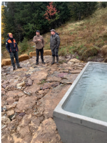
Réaménagement d'un point d'abreuvement bovin, afin de limiter les phénomènes d'érosion au-dessus d'une zone humide (alpage du Collet d'Allevard)
